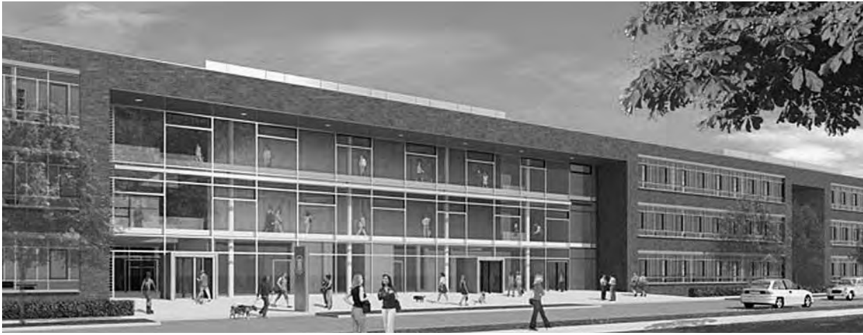
Ansicht des neuen Klinikums am Bünteweg. Der Rohbau ist fast fertig. Untergebracht werden vier Kliniken: Klinik für Pferde, für Kleintiere (Hunde und Katzen), für Zier- und Wildvögel und 4. für Heimtiere (Reptilien, Kaninchen u.a.). Der Einzug der Kliniker ist für Herbst 2009 geplant.
